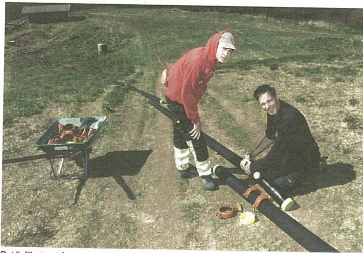
Det är företaget Innosnow med far och son Carl-Johan och Fredrik Hedin som bygger Rödeby vintersportanläggning. De ligger bland annat bakom skidanläggningen Vallåsen på gränsen mellan Skåne och Halland.
